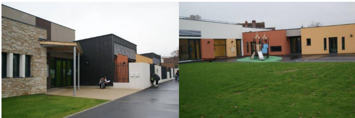
Groupe scolaire de Mainville
