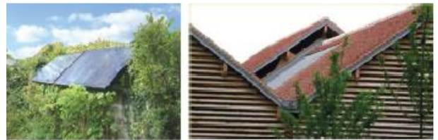
La pose de capteurs dans un espace végétalisé ou entre deux toits limite l'impact visuel
